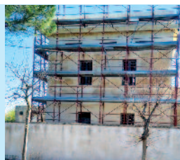
Al di sopra e al centro delle finestre del piano superiore troneggia ben inciso: 1930.
