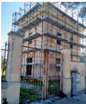
La cabina, oggi proprietà privata, in fase di restauro.
