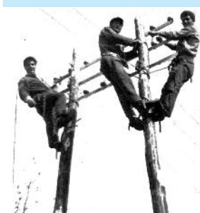
1958-costruzione rete elettrica. Dalla sinistra, Roberto Sterlecchini, al centro non riconoscibile e Rodolfo De Santis.
